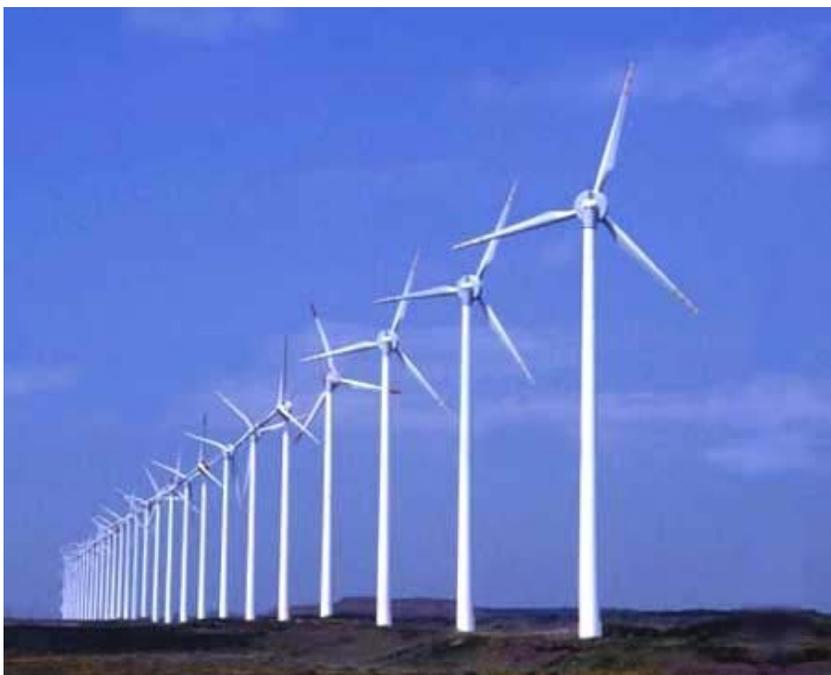
利用風力推動風車旋轉發電機，叫風力發電。風力發電主要是使用螺旋槳型風車，有時亦採用錐形或新式多翼型等。風力發電的優點是不會造成公害，而且取用不盡。但風力發電也有困難，就是風向和風力時常改變，且無法將能量集中。為了解決這些問題，所以需組合特殊裝置。目前已有3000千瓦的風力發電設備在運轉。
