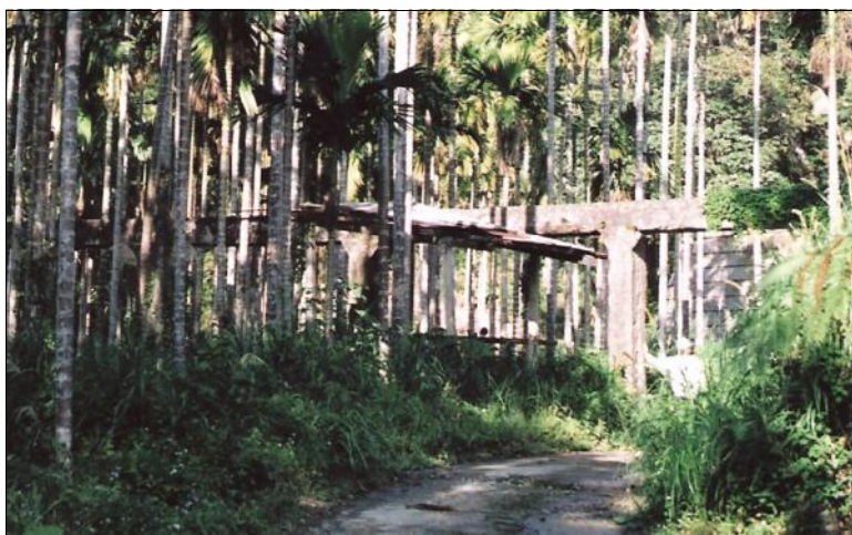
圖 2-2：新竹縣關西鎮東山里窩壠的水梘橋（過水橋）
